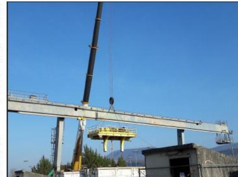
L'expérimenté grutier a réussi une manœuvre parfaite pour soulever, dans un premier temps, une partie du pont roulant.
