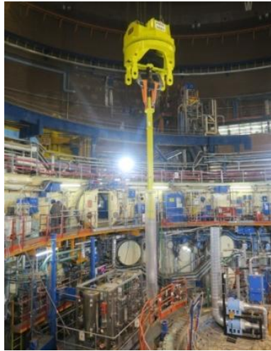
Extraction des derniers bouchons de la dalle
