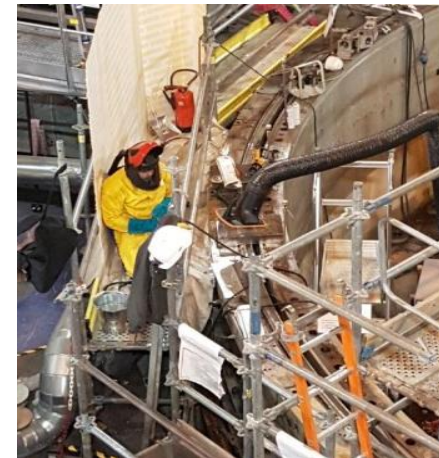
Soudure du Grand Bouchon Tournant et du bac JML (Joint Métal Liquide)
