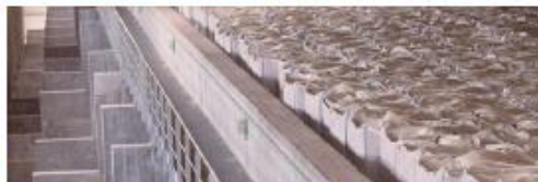
Le traitement du sodium avec l'installation TNA (vidange/transformation en soude inertée dans des blocs de béton)
