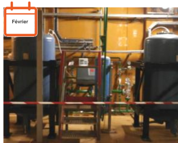
Mise aux normes séisme de réservoirs
