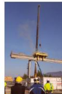
Le démantèlement de l'ancienne station de pompage
