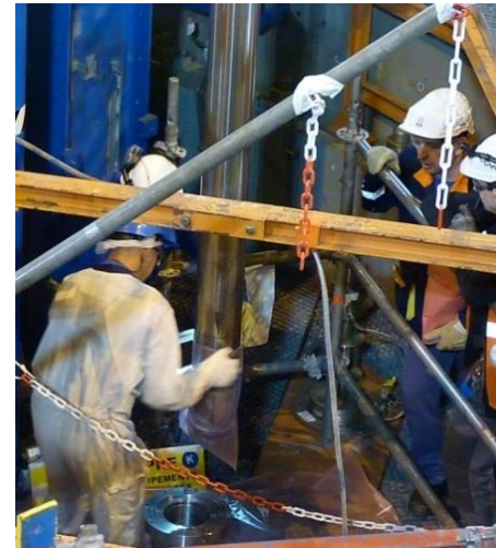
Enlèvement du periscope et du projecteur de la dalle
