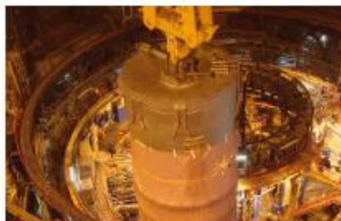
Le démantèlement des 16 « gros composants » (pompes primaires et secondaires, échangeurs)
