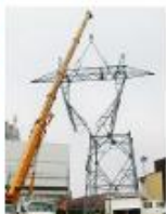
Le dépose des lignes et pylônes d'évacuation de l'électricité
